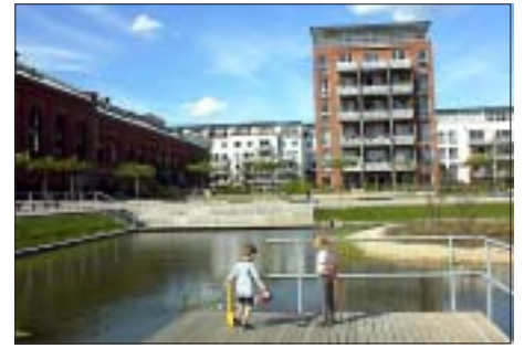
Auf dem ehemaligen Gaswerks-Gelände in Bahrenfeld sind durch Mitwirkung der SPD 270 Wohnungen für Familien entstanden.
