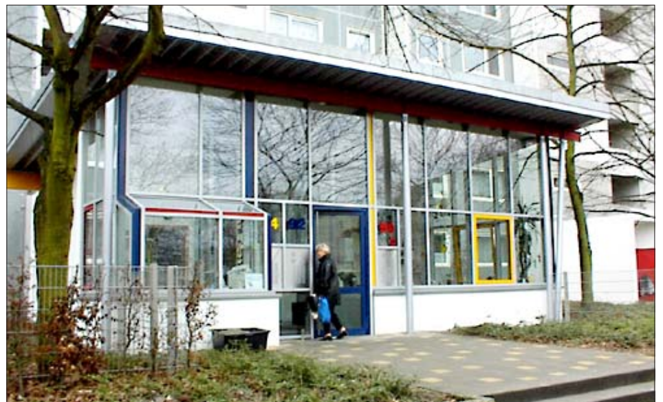
Wichtiger Bestandteil der Sozialen Stadtteilentwicklung ist der Bau von Pfortnerlogen in großen Wohnsiedlungen. Das Bild zeigt eine Loge am Osdorfer Born.
